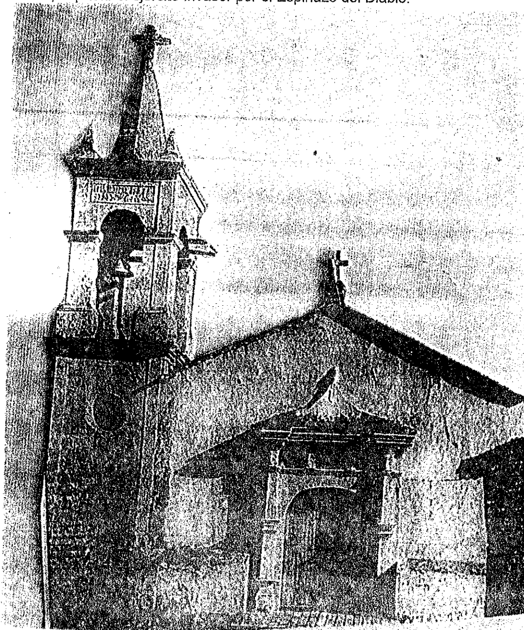
Fotografía 13. La iglesia del lugar que sirvió de fortificación al invasor data a mayo 11 de 1857.
