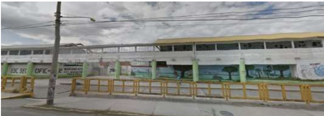
Figura 3. Vista externa de la escuela “Sor Juana Inés de la Cruz”
