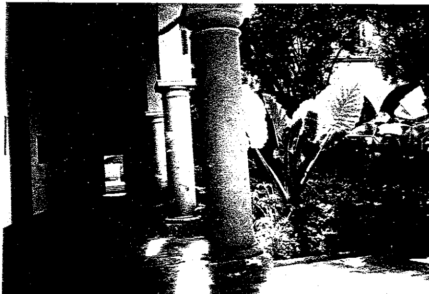
Foto No. 7.- Pilares de uno de los patios internos de la Casa Grande.
