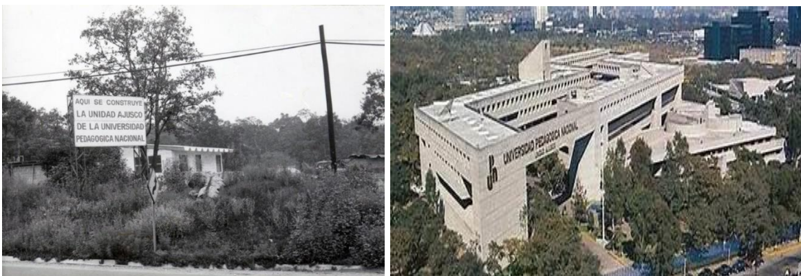
Imagen 1: La primera imagen nos muestra el comienzo de la construcción de la UPN Ajusco 1 . La segunda imagen nos muestra como es la UPN en la actualidad.
