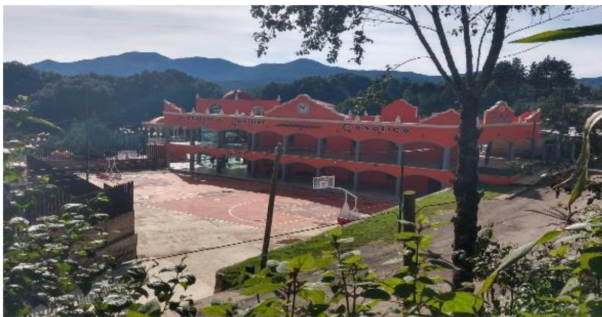
Actual edificio de la Presidencia municipal. Fotografía tomada por Anselmo Clemente de Jesús
