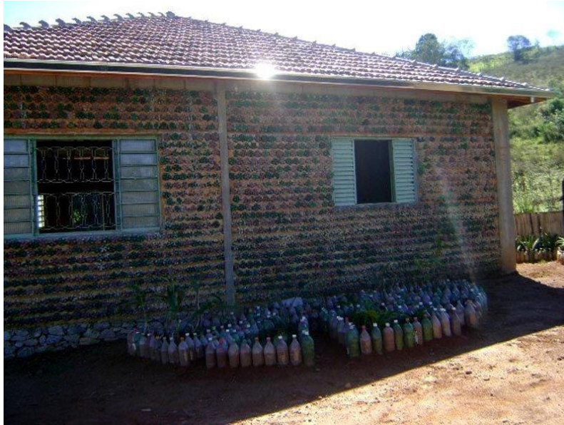
Imagen 16. Casa construida con botellas de PET. Fuente: (EcolInventos, 2018)
