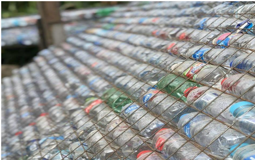
Imagen 17. Muro hecho a base del sistema de PET aligerado. Fuente: (Ecolventos, 2018).
