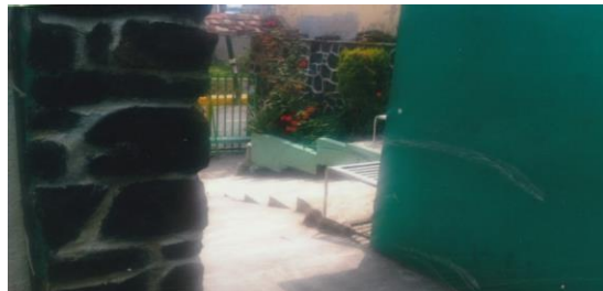
Salida de emergencia. Fuente propia
