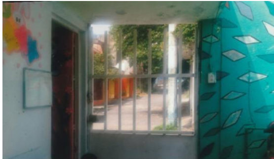
Salida de emergencia. Fuente propia
