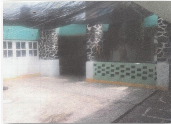
Patio del centro
