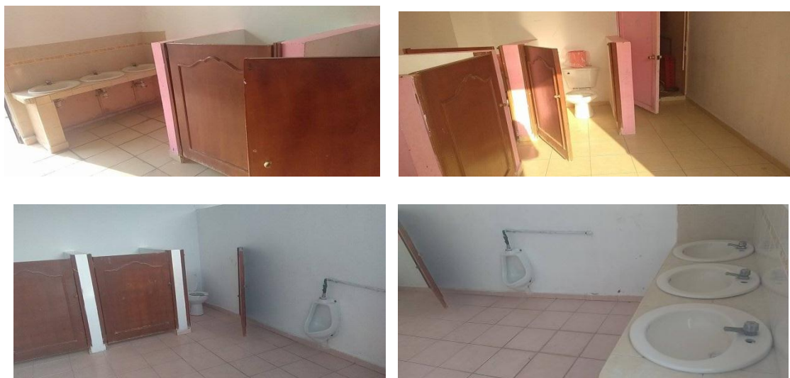
Anexo N°13 -Fotografía N°1 de sanitarios.
