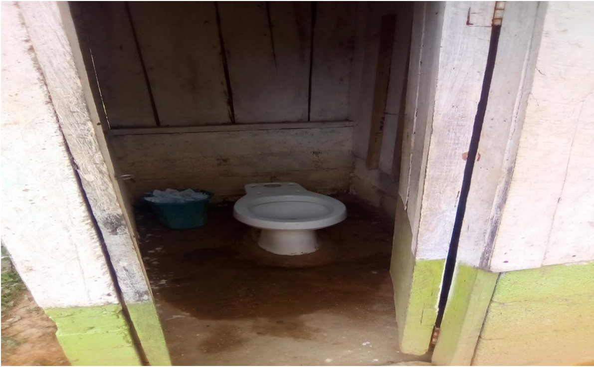
Interior del servicio sanitario.
