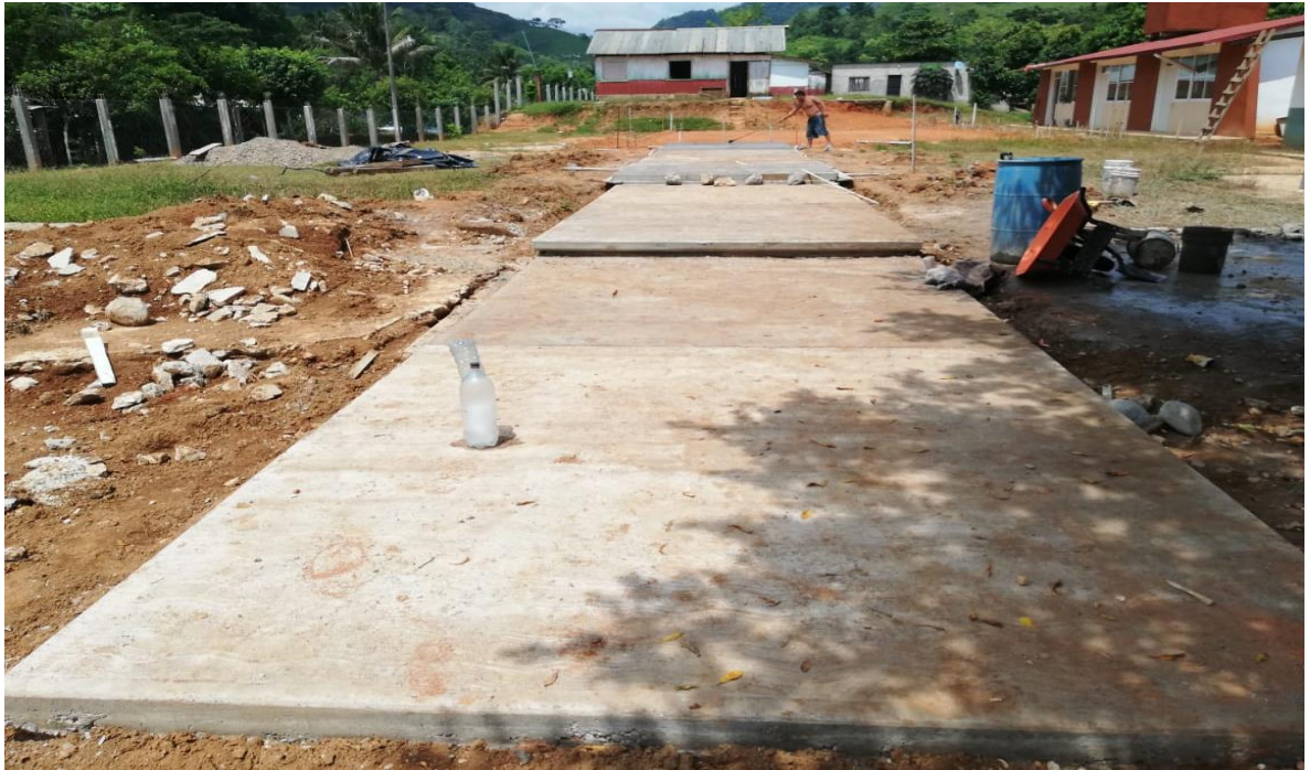
Colocación del andador para conectar la entrada con la plaza cívica.
