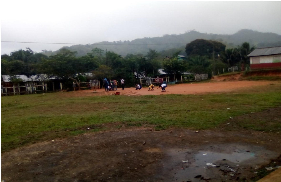
Cercado de varengas en muy malas condiciones.
