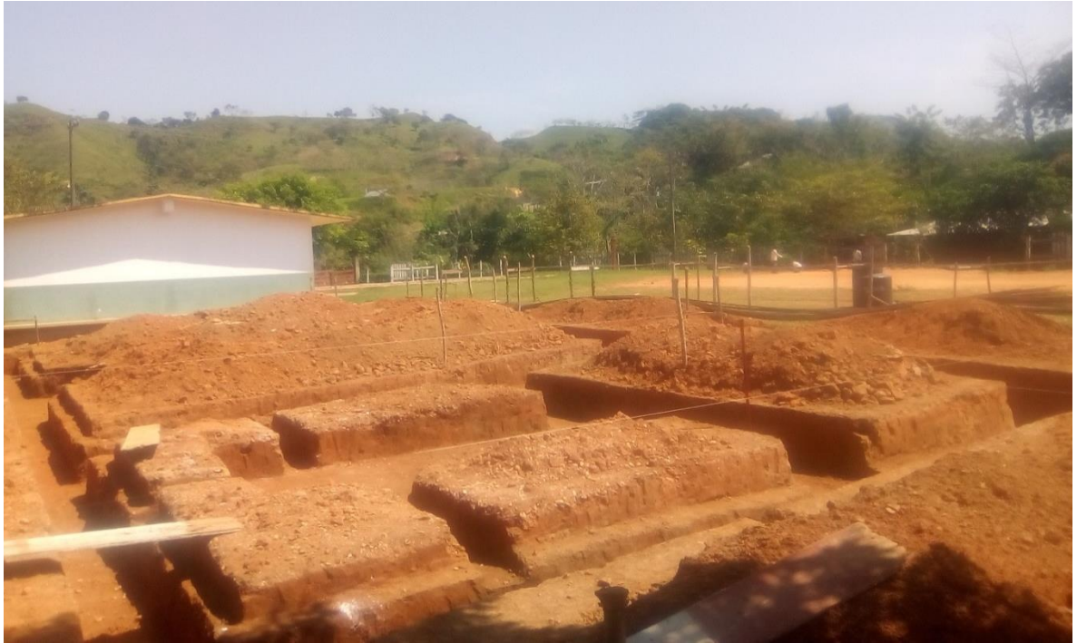
Excavación de la tierra para colocar las bases de la edificación.
