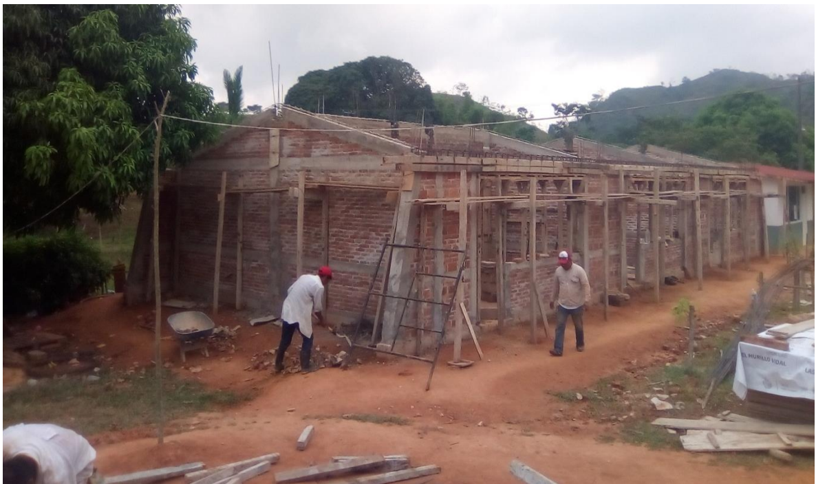
Construcción de los salones de clase, la dirección y los servicios sanitarios.
