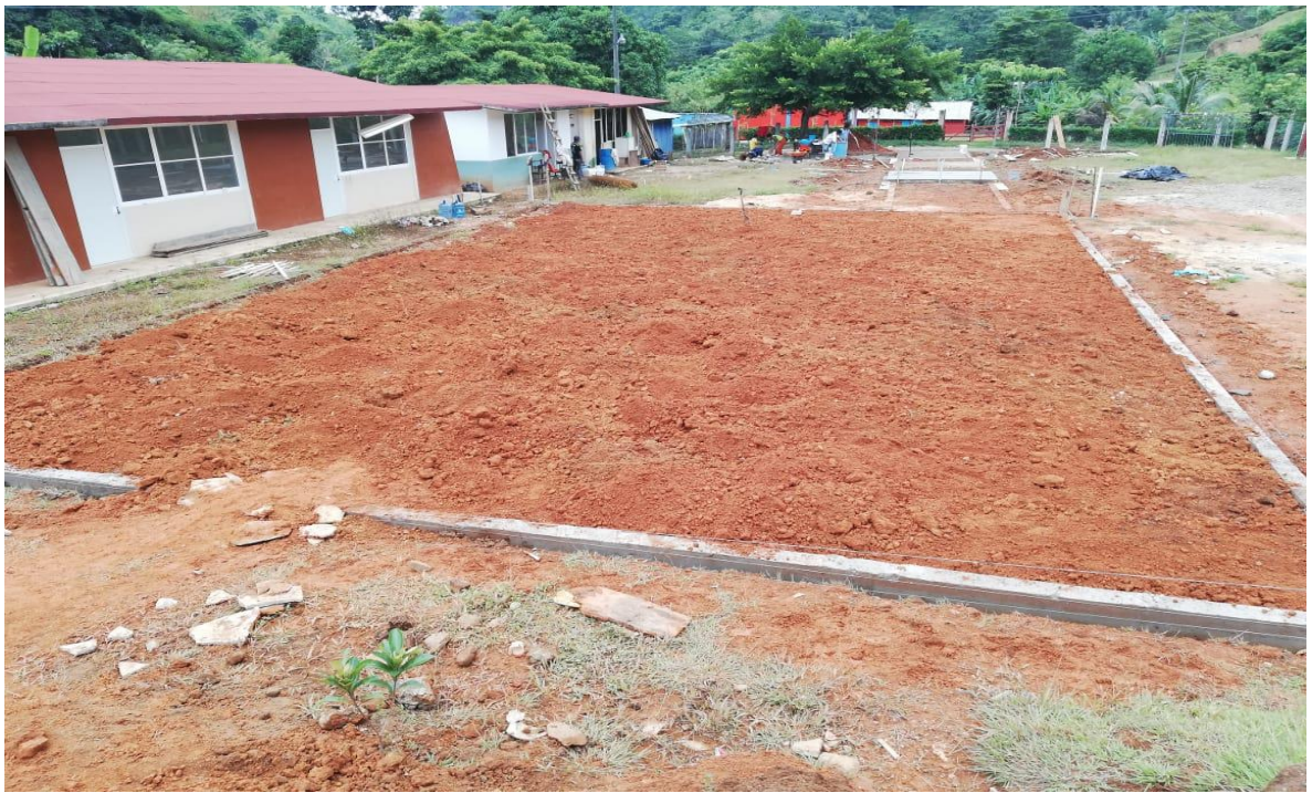
Construcción de la plaza cívica después de la primera edificación.
