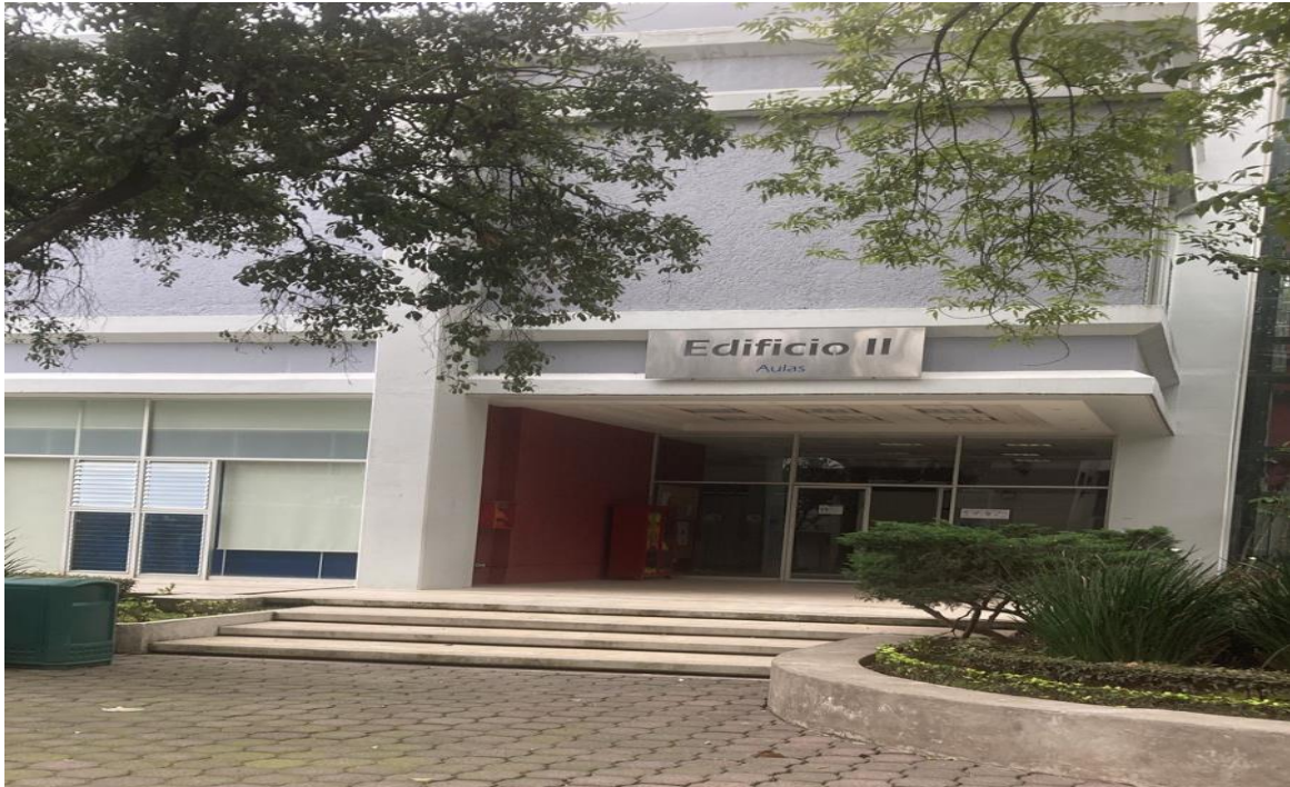
Imagen referencial 4. Edificio II. Aulas. Autor: José Luis Ruiz (2022).
