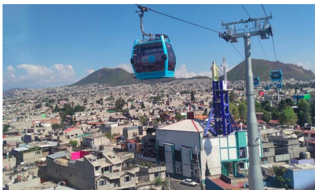
Imagen 4. Exterior de la estación.
