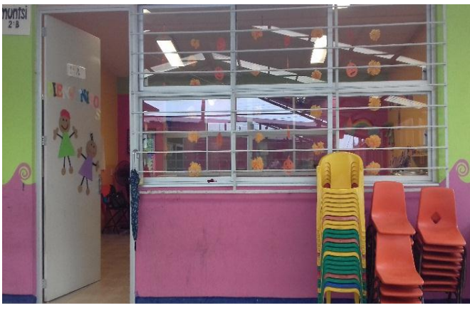
Exterior del salón de clases de primer grado
