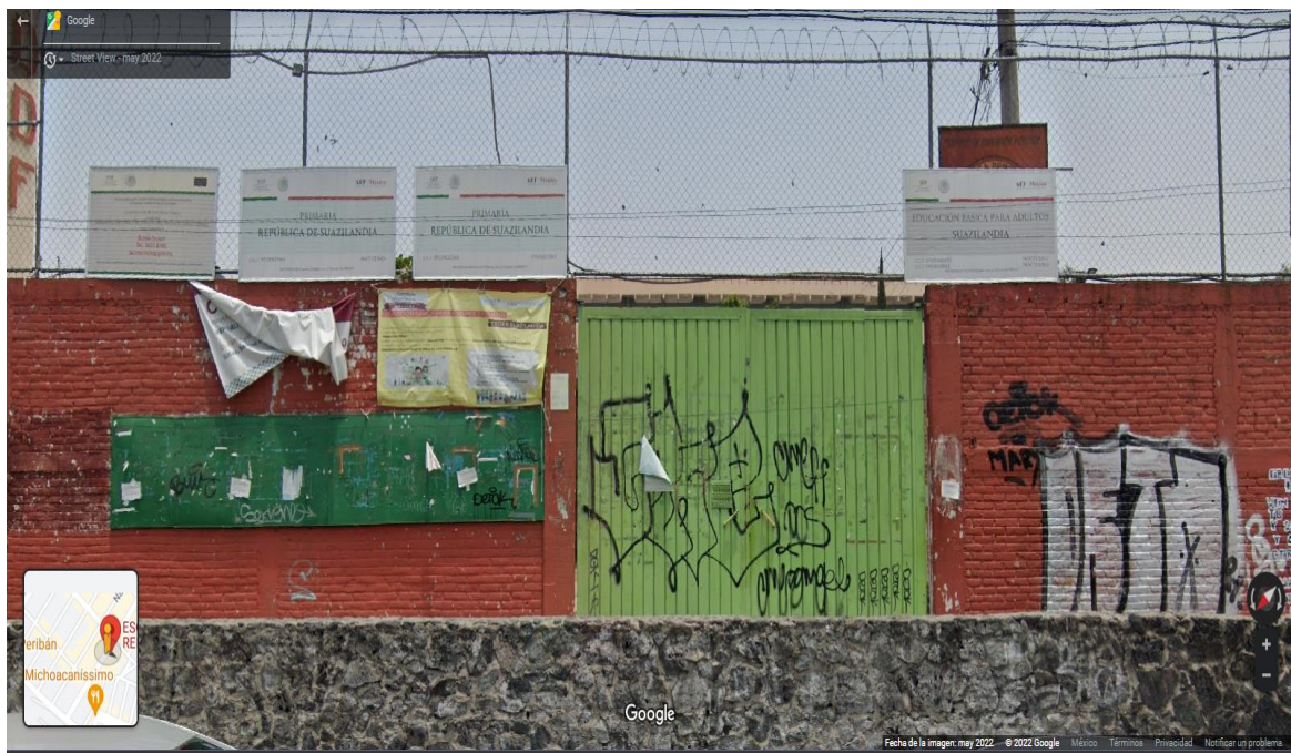
Fachada de la escuela Primaria República de Suazilandia 2
