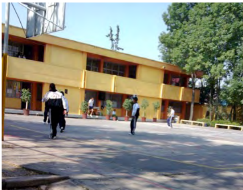
Figura 4.5. Vista poniente del edificio de la Dirección y ubicación de los grupos de tercer grado en la planta alta
