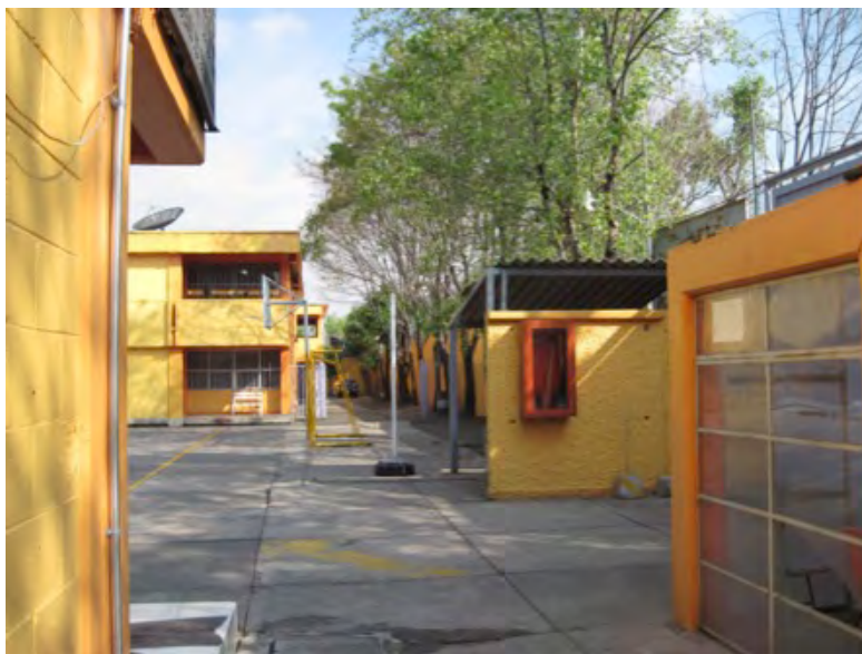
Figura 4.4. Vista del acceso al estacionamiento y rejas para el encierro de los estudiantes durante el recreo
