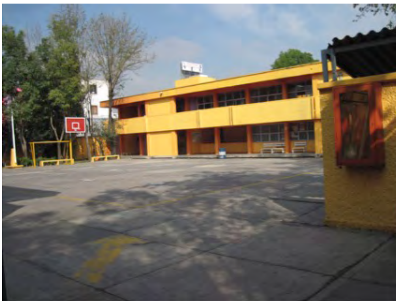
Figura 2.1. Vista del patio central desde la portería. Al fondo en planta baja, el cubo de las escaleras y la entrada a los baños tras el muro
