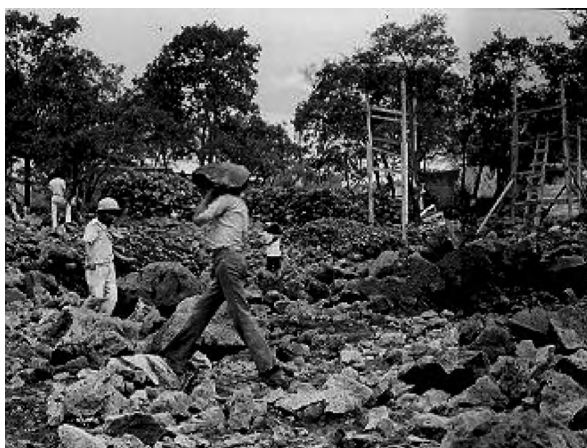
Figura 5. UPN, remoción de condición original de piedras basálticas
