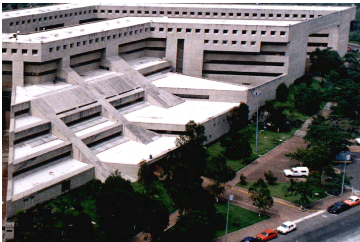
Figura 60. UPN, fachada posterior de la biblioteca
