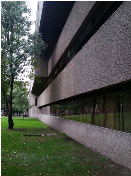
Figura 58. UPN, horizontalidad acentuada con largos ventanales (7)
