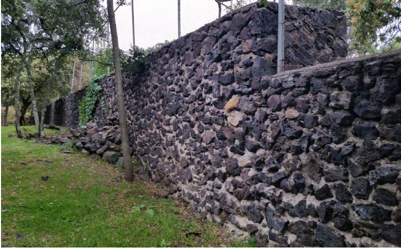
Figura 53. UPN, barda con murete de piedra volcánica (2)
