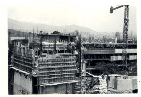
Figura 49. UPN, grúa gigante en la construcción
