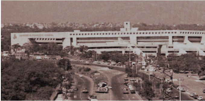
Figura 50. UPN panorámica recién construida
