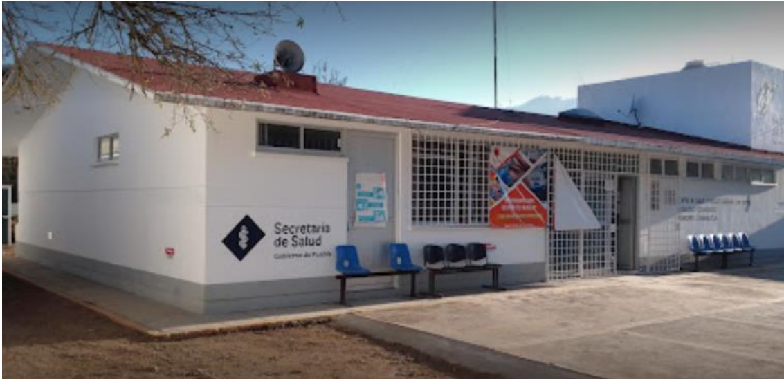
Observación de la parte externa del centro de salud de Coahuixco, Chignautla.
