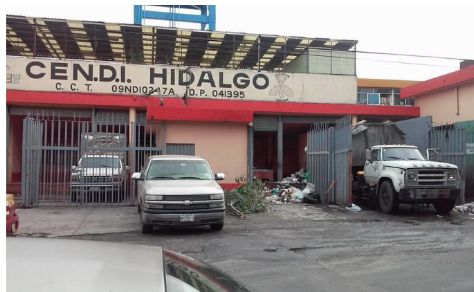
Foto 2.-Vista exterior del Centro de Desarrollo Infantil Hidalgo donde se observa el depósito de basura Fuente: Propia
