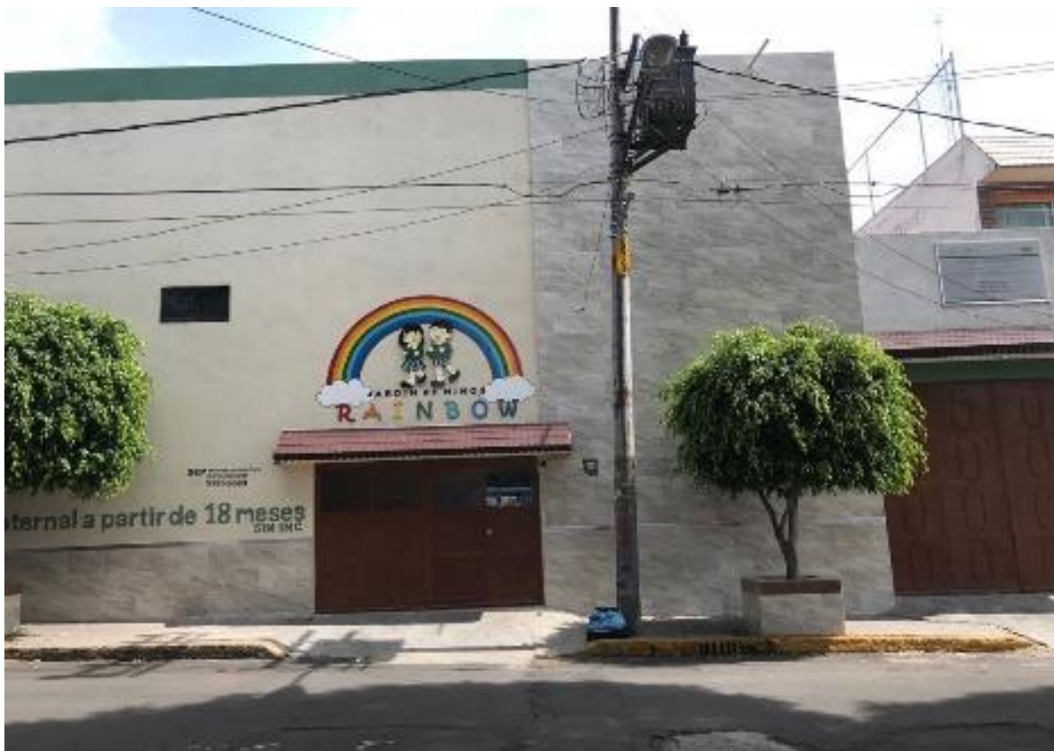
Fotografía 13: Fachada del kínder por fuera (AP)
