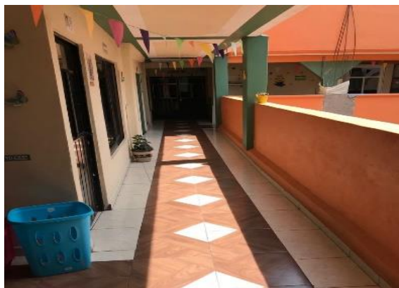
Fotografía 18: Pasillo del Segundo Piso (AP)
