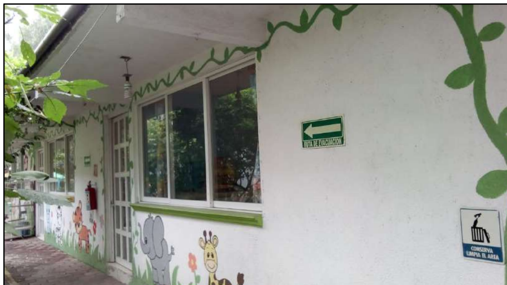
Foto.6. Sanitización y preparación de áreas para tener aprendizajes al aire libre
