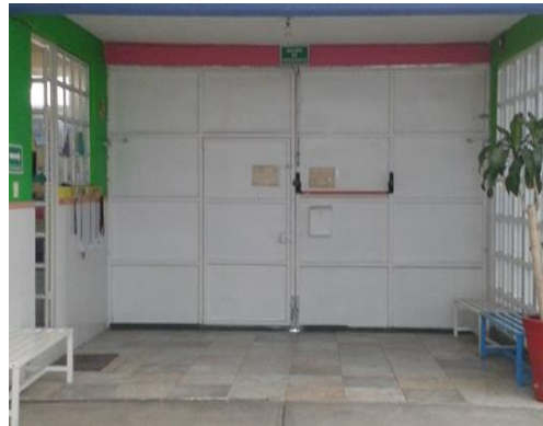
Foto 14.-Salida de emergencia.
