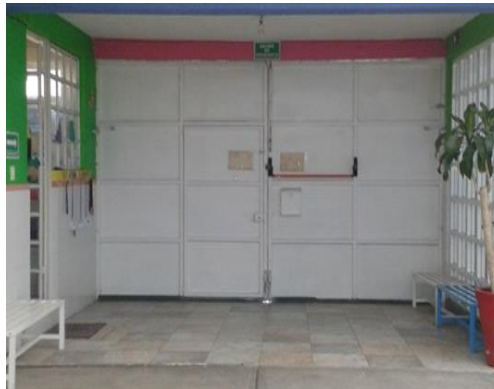
Foto 14.-Salida de emergencia.
