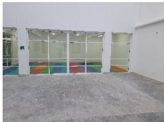
Foto 2. Patio y salón de usos múltiples.
