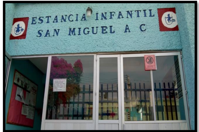
La entrada a la recepción
