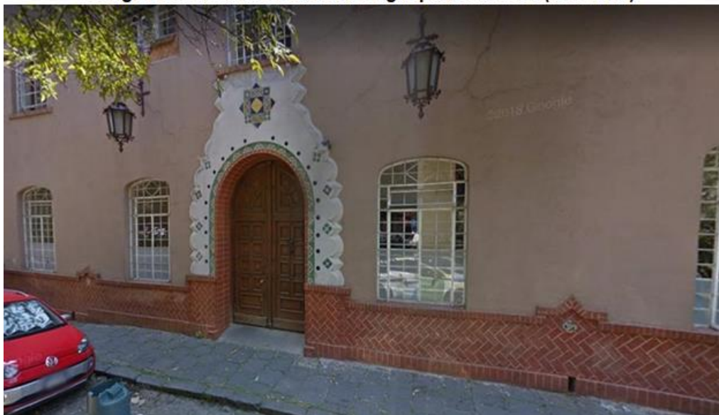
Imagen 1. Fachada de la Casa Hogar para Varones (CAHOVA)
