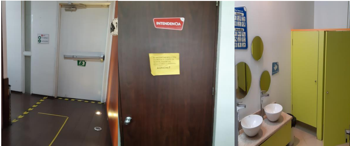
Fotos 27, 28 y 29.-Salida de emergencia, área de intendencia y baño de niñas.
