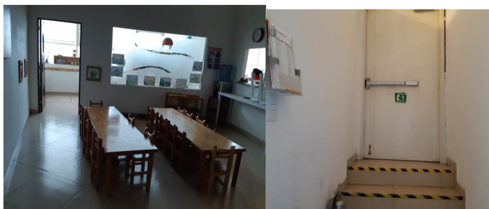
Fotos 33 y 34.-Comedor y Salida de emergencia.
