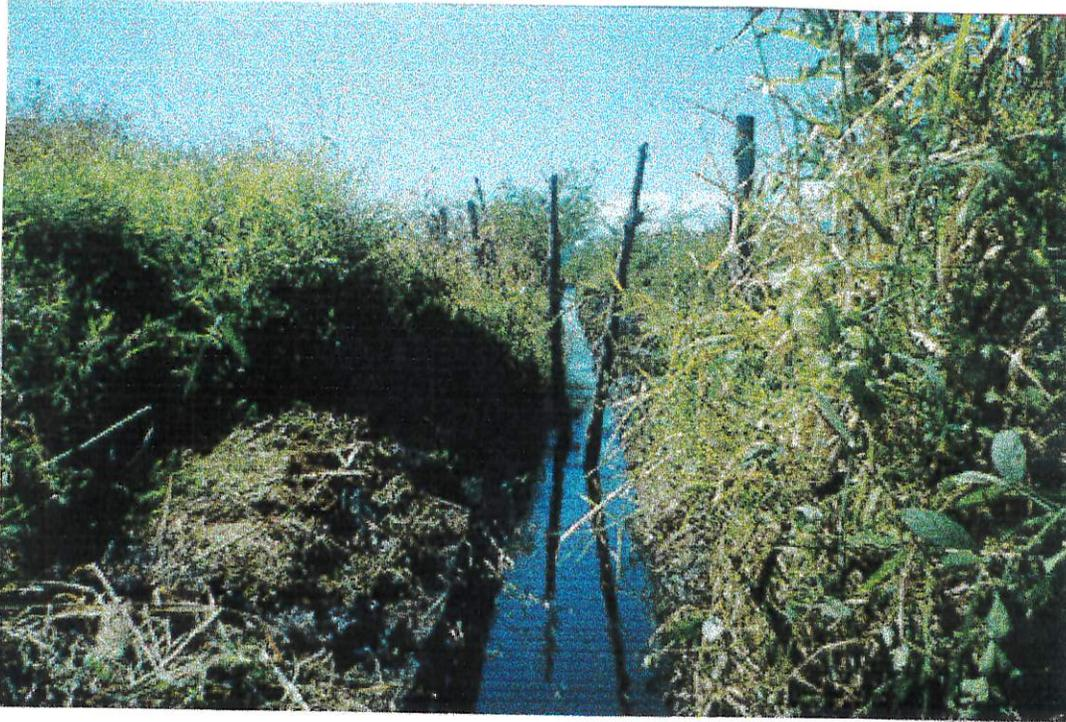
Infraestructura existente para la conducción del agua desde el nacimiento. Consiste en un canal con una estructura de mampostería hecha de piedra y mortero con protección de enjarre en las áreas de mayor pendiente del agua.
