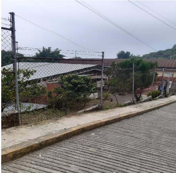
Instalaciones Escuela primaria Lic. Benito Juárez. (15 de noviembre de 2022)
