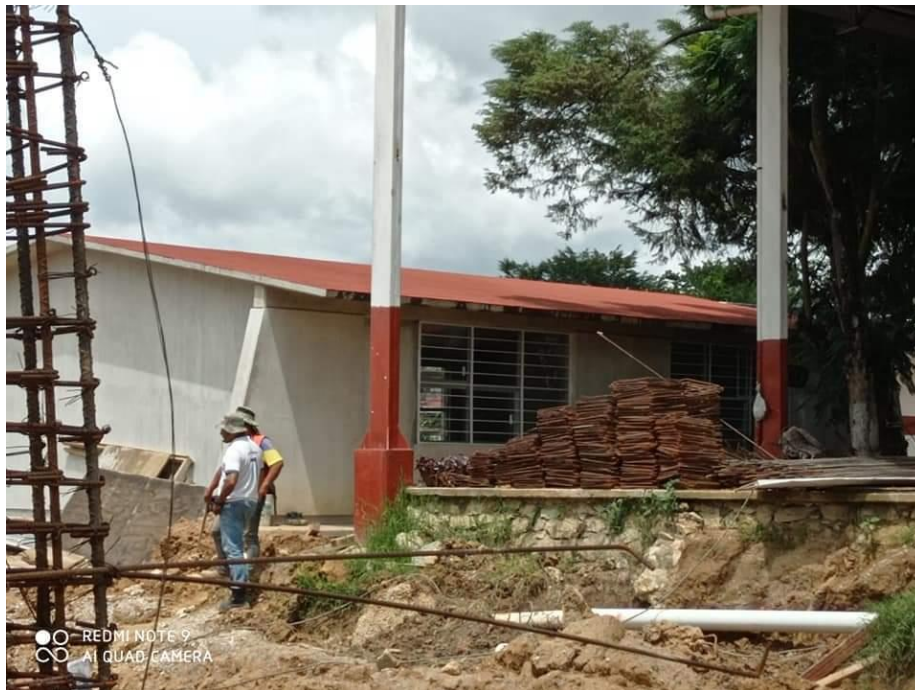
Imagen 12. Proceso de construcción.
