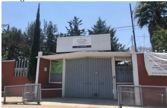
Figura 1. Soto B. (2023). Fachada de la Telesecundaria Motolinía. Entrada principal. Vereda la Resurrección Municipio de Texcoco Estado de México. Recuperada del archivo de la Investigación.
