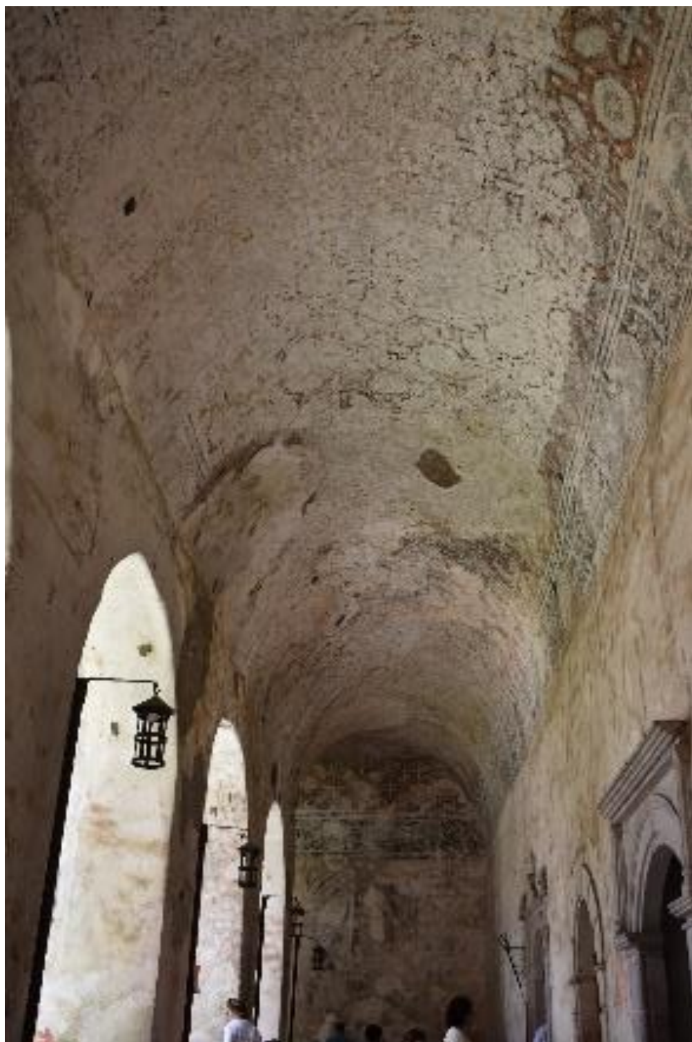
Anexo Q. Muros del Ex convento de San Juan Bautista
