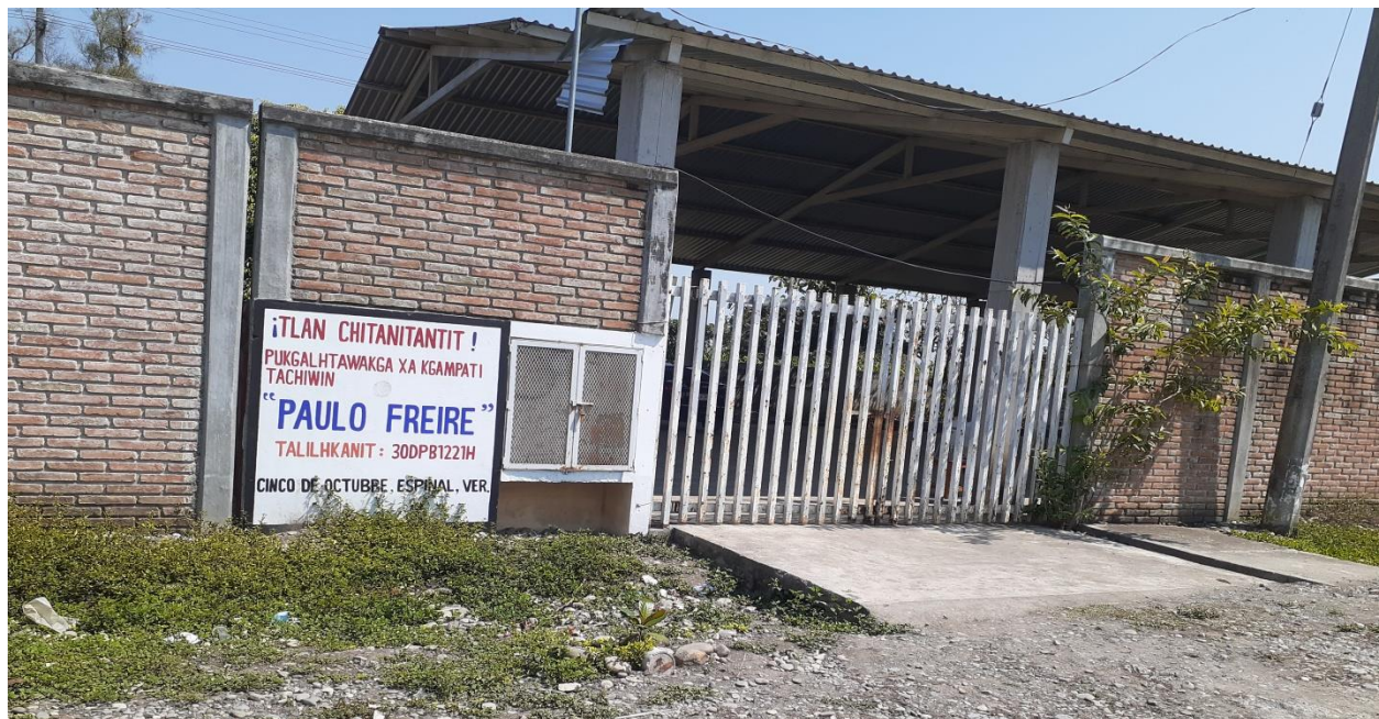
Fachada de la entrada de la escuela primaria bilingüe
