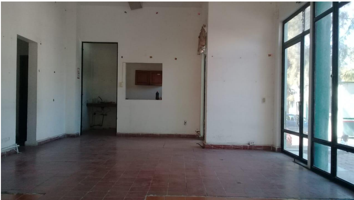
Infraestructura de la Casa de Día por dentro
