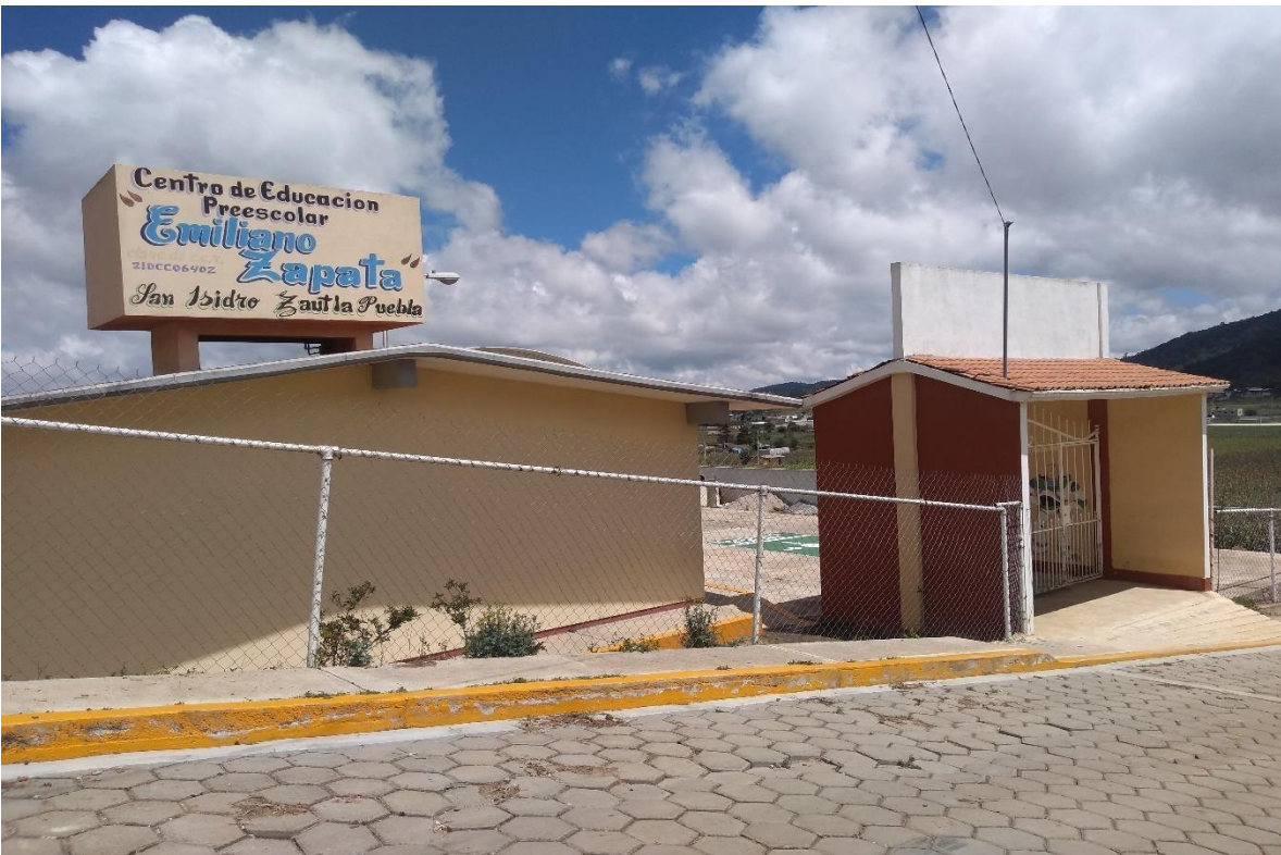
Foto de acceso al inmueble
