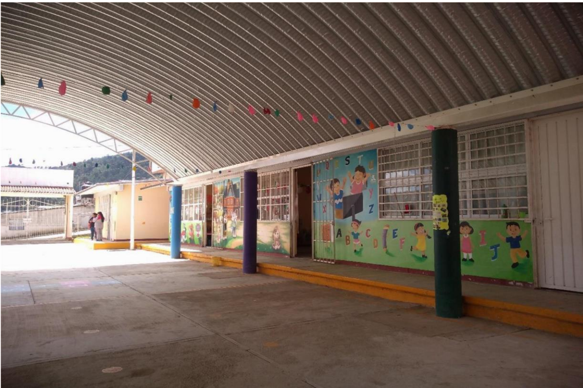
Foto de las aulas de perfil
