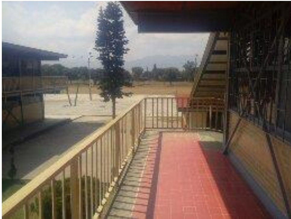
EDIFICIO DONDE SE UBICA LA SALA DE JUNTAS Y EL TALLER DE INFORMÁTICA
