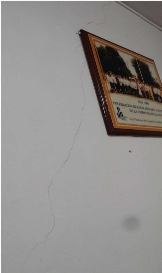
**Fig. 18** Cuarteadura en área de Dirección.
