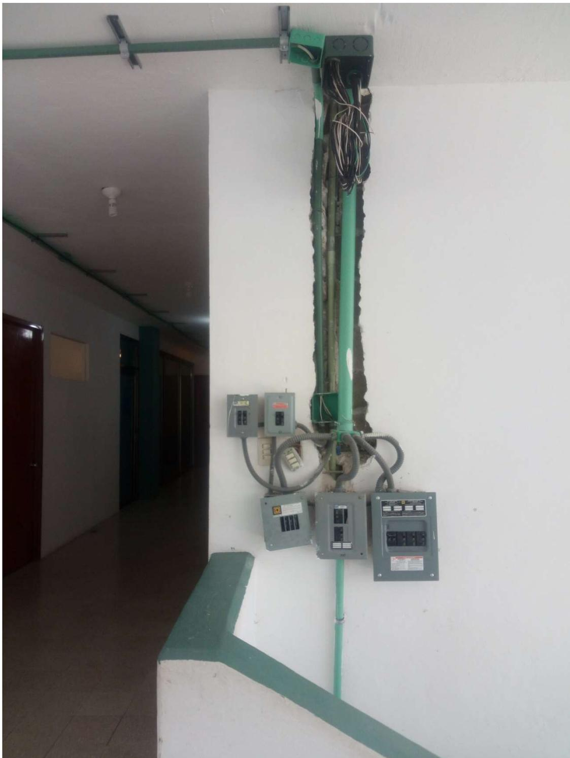
**Fig. 24** Conexiones eléctricas inadecuadas.
