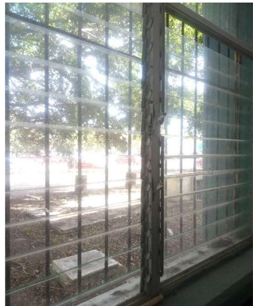
**Fig. 21** Ventanas dañadas.
