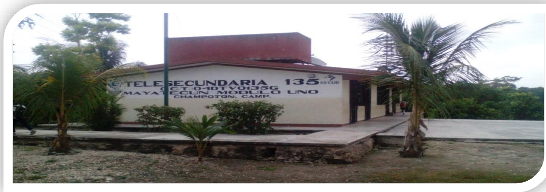
Imagen 5.- Vista General del Edificio Principal
