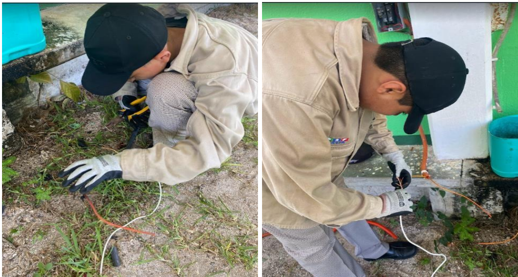
Figura 16. Equipo 1: Reparación en instalación eléctrica
