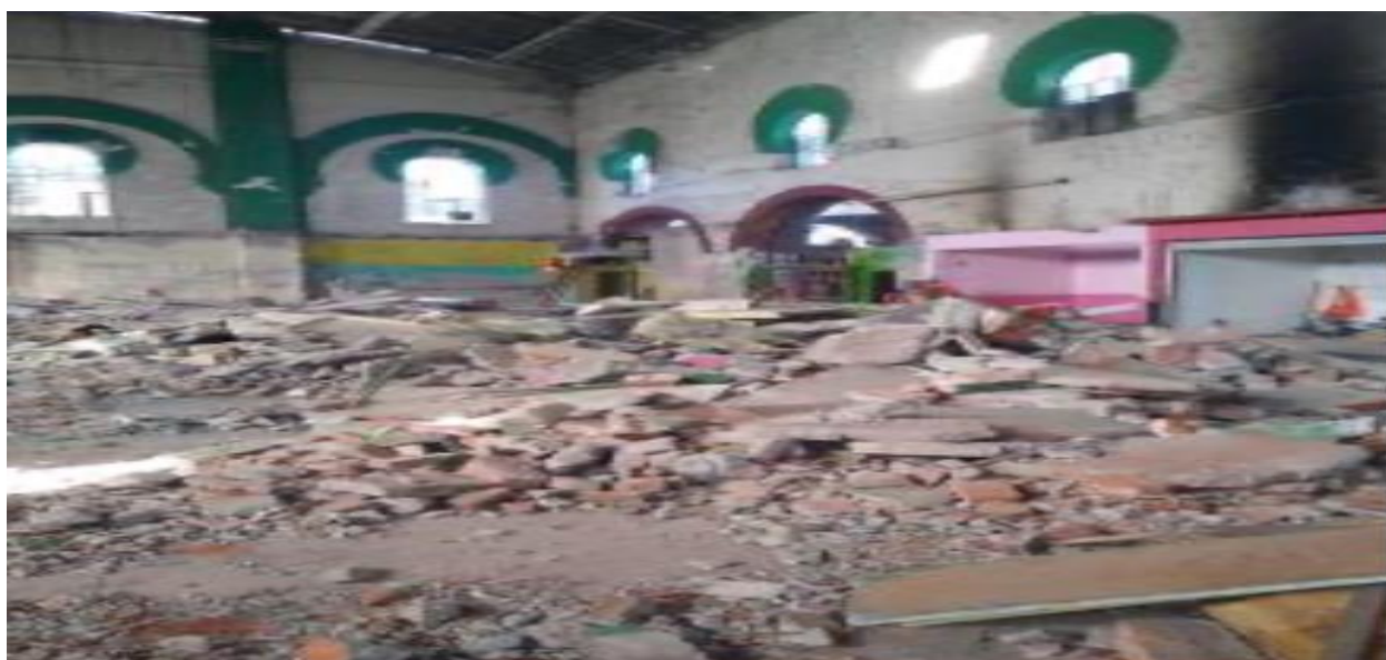
Figura 6. Nave mayor antes de ser intervenida.
