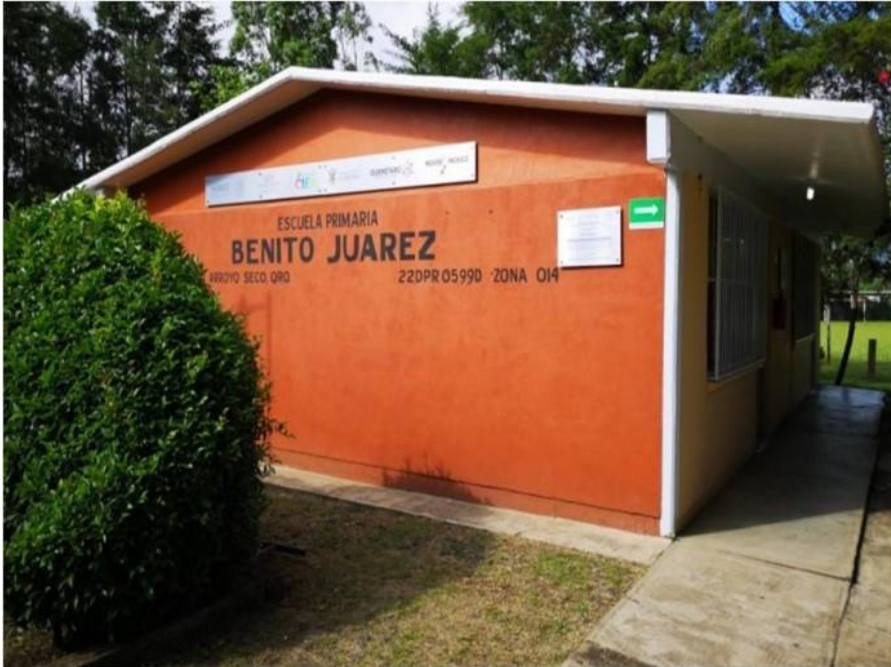
Escuela Primaria Benito Juárez, instalación.
