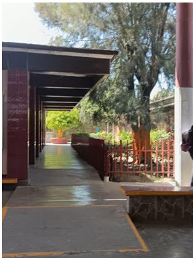
Figura 5. Pasillo aula de artes
