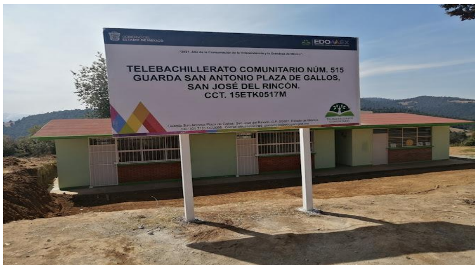
Figura 3. Fachada del Plantel
