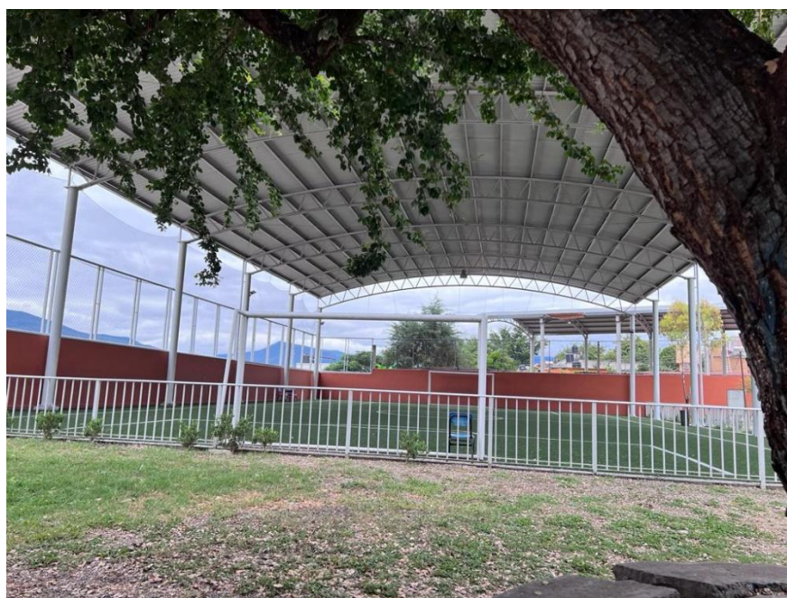
Cancha techada de futbol con pasto sintético.
