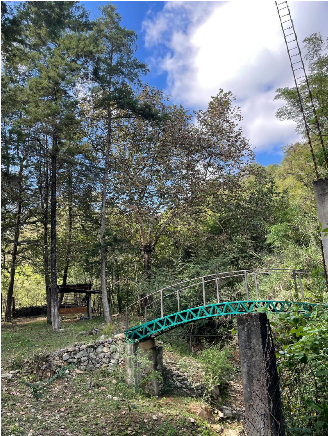
Anexo 6 Se presenta una fotografía del arroyo y la maya deteriorada que hace alusión a la seguridad de los alumnos, tomada por un dispositivo móvil.
