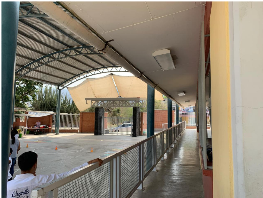
Infraestructura de la escuela
