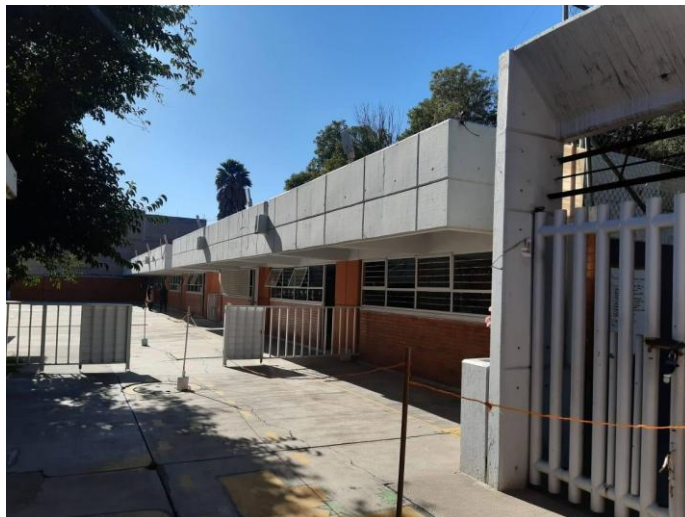
Figura. 4 principal; y aulas 1er y El segundo lado cuenta con baja y las niñas, pequeños
