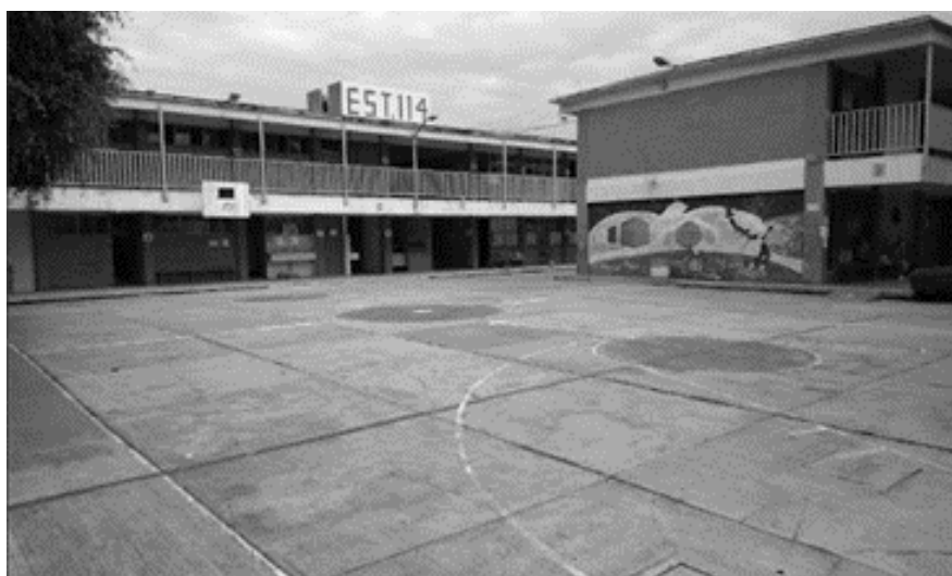
Figura 6. Se muestra el patio principal, de la Escuela Secundaria Técnica 114.
