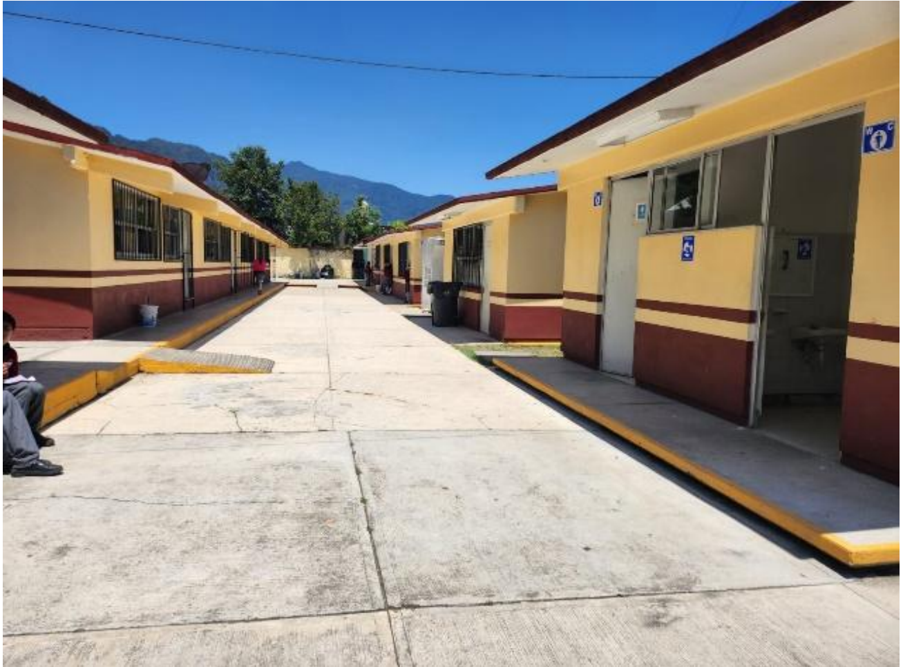
Pasillos y aulas, sección A, B Y C
