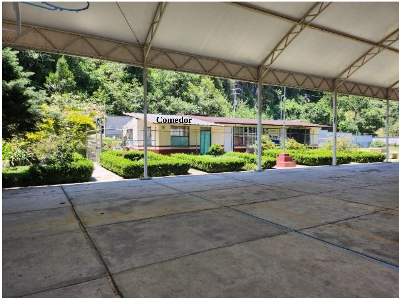
Cancha de baloncesto y comedor.
