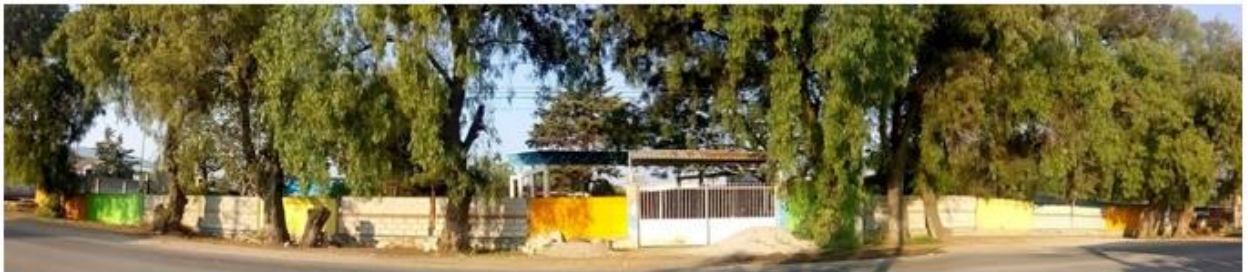
Ilustración 18 Entrada principal de personal directivo y educativo
