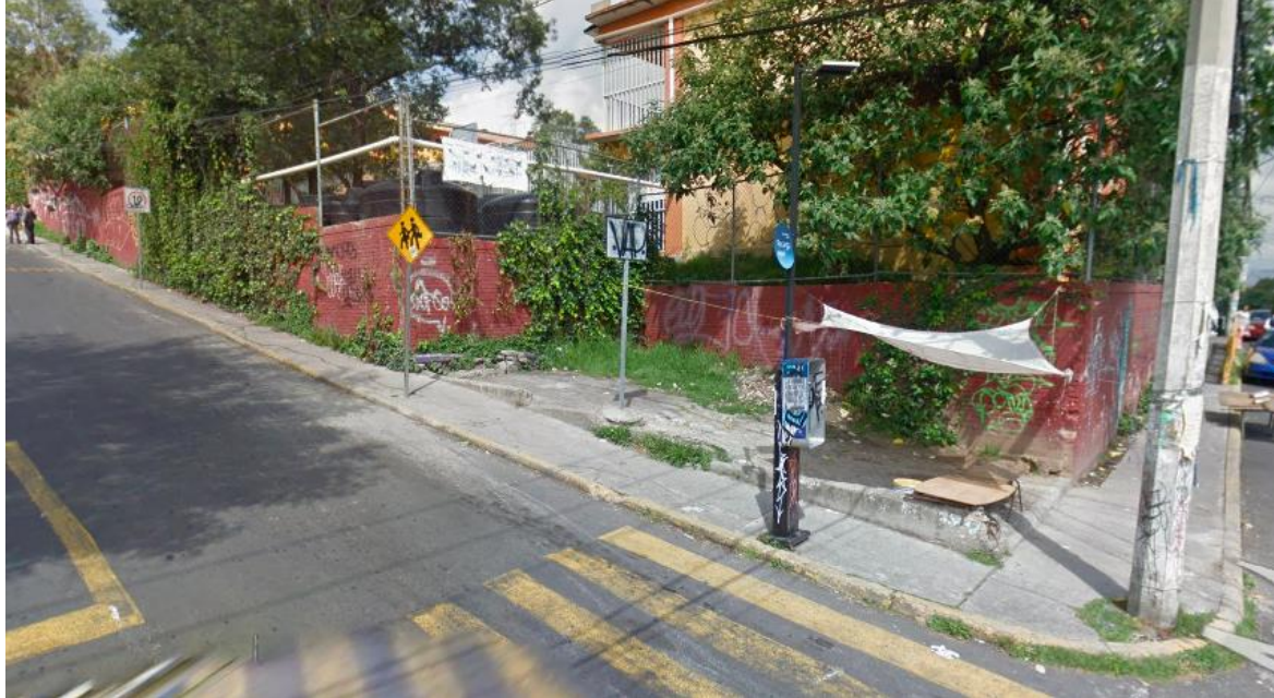
Figura 7. Espacio derruido. Foto: Archivo personal
