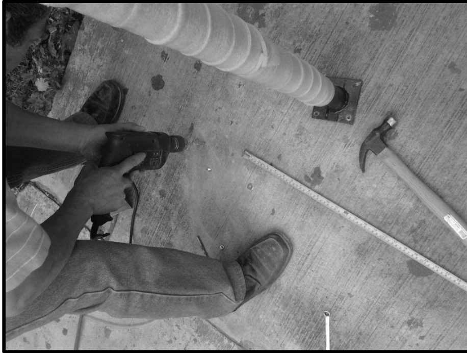
(Foto 1b) El anclaje
