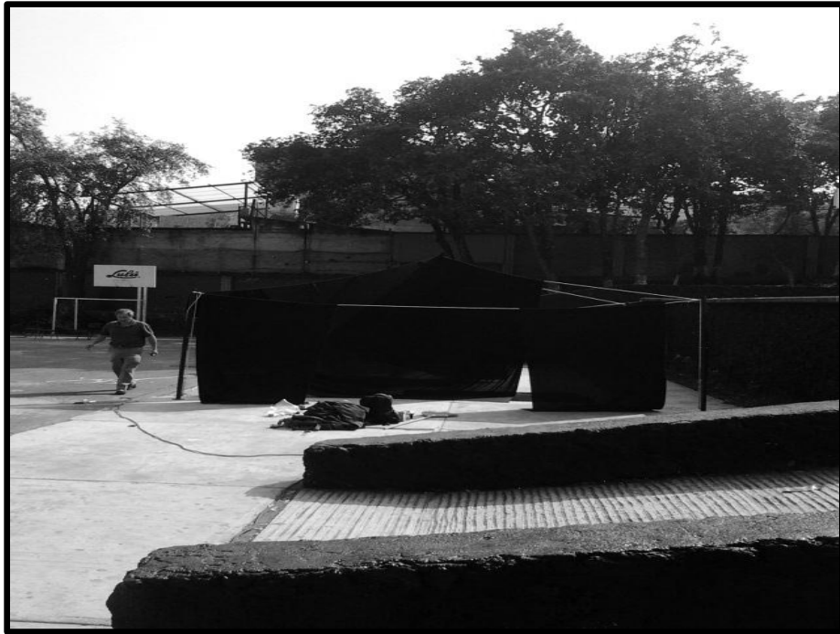
(Foto 4b) En construcción
